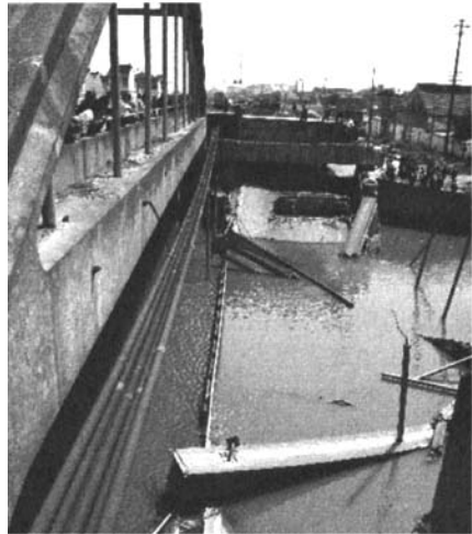
图1 桥梁坍塌现场
