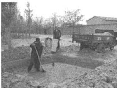
图 2-1 铺渗透层的过程
