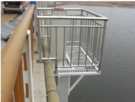
图 3-4 增设观测基点护栏
