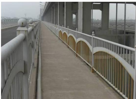
图 3-8 铸铁护栏锈蚀
