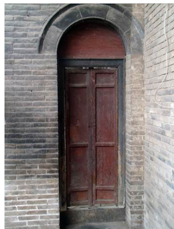
图 3-17 四号民居的内门实景
