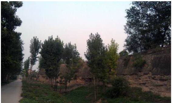
图 3-51 寨卜昌村的寨墙现状
