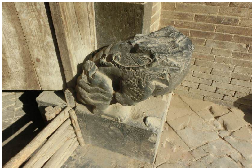
图 2-6 八号民居被砸毁的门墩现状
