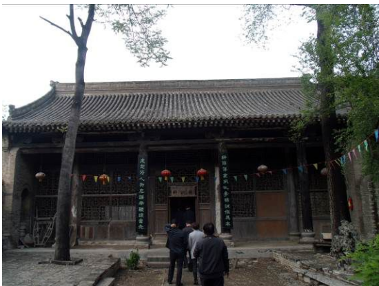
图 3-31 三号民居的正房实景
