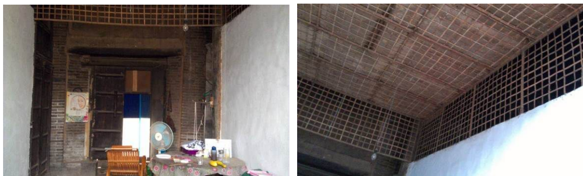
图 4-5，图 4-6 一号古民居室内生活现状
