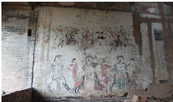
图 4—25 壶关县罗东掌村二仙奶奶庙正殿壁画（自摄）
