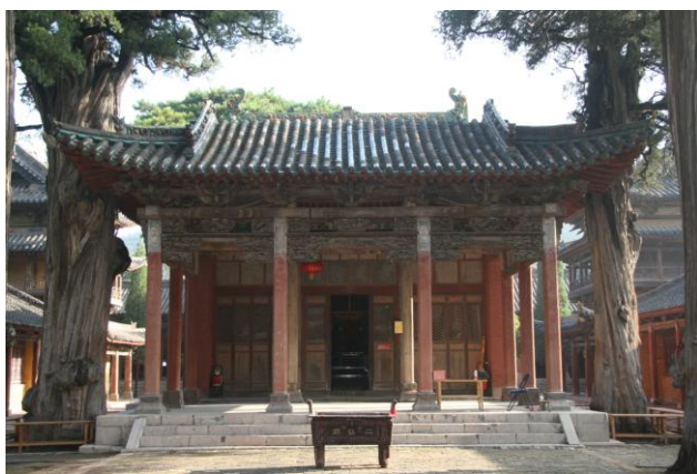
图 2—4 陵川县西溪二仙庙献殿（王璐伟提供）
