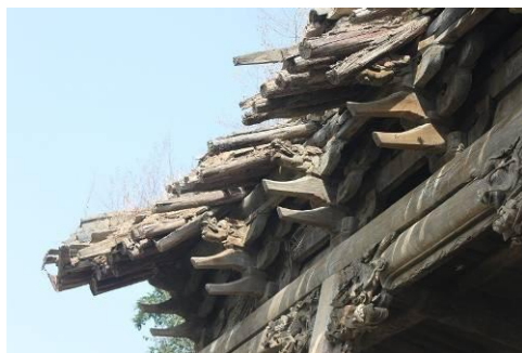
图 4—27 壶关县东旺宅二仙庙正殿斗拱（自摄）
