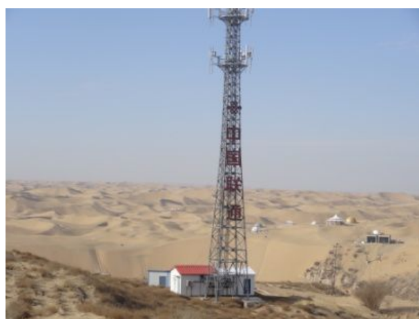
(a) 钢结构通信塔
