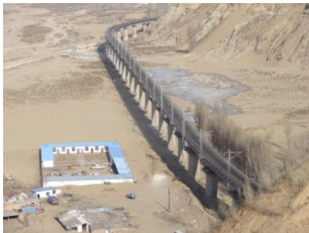
(b) 钢结构桥梁
