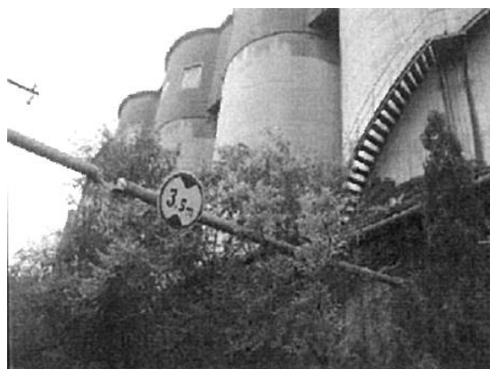
(b) 焦化厂储煤塔外观现状
