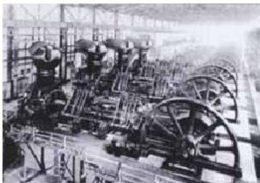
（a）原中心动力站内景
