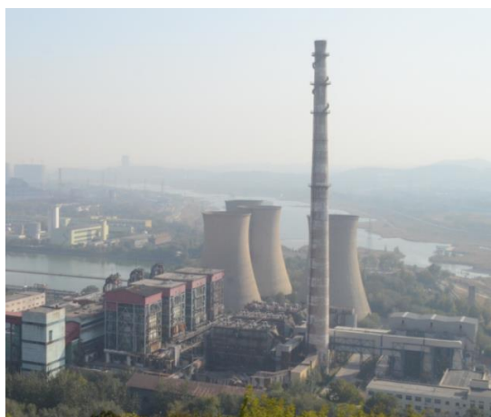
(a) 发电厂冷却塔现状
