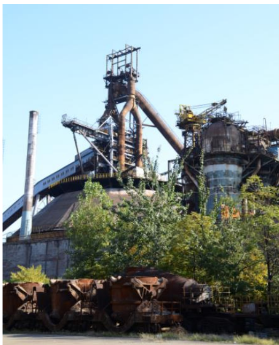
(a) 首钢石景山工业区 3#炼铁高炉现状
