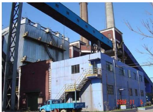
(a) 烧结车间厂房现状
