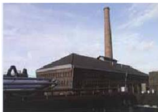
（b）鼓风机房综合体
