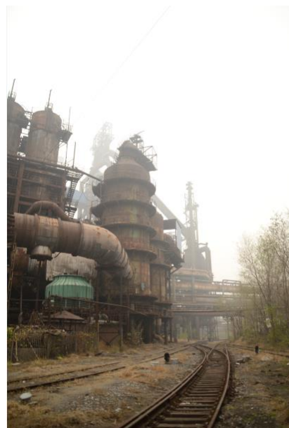
图 5.2：厂区内遗留建筑和污染的土地
