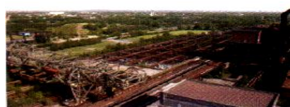
图 4.5: 杜伊斯堡风景公园完整的保留了钢铁厂的设施
