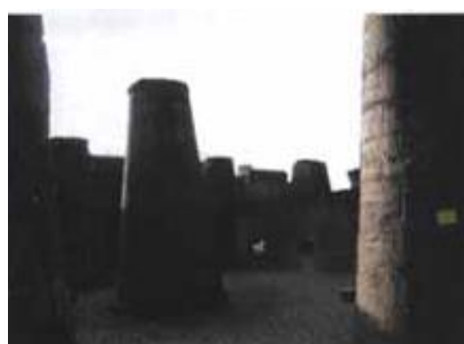
(b) 拆除顶盖的矿石料仓改造成综合活动场所
