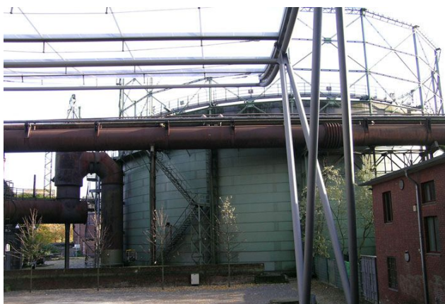
图 3.3 煤气储存罐外景
