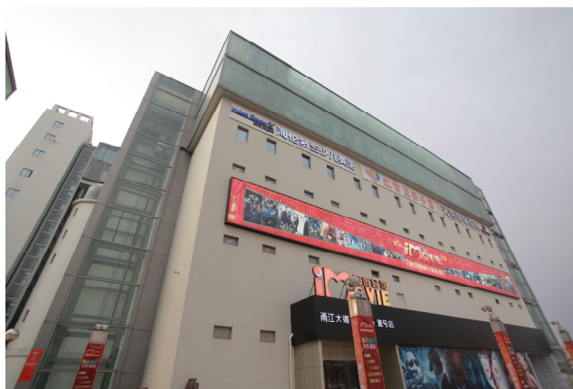
图 3.22 改造后的工业建筑
