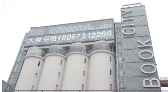
图 3.24 改造后的工业建筑
