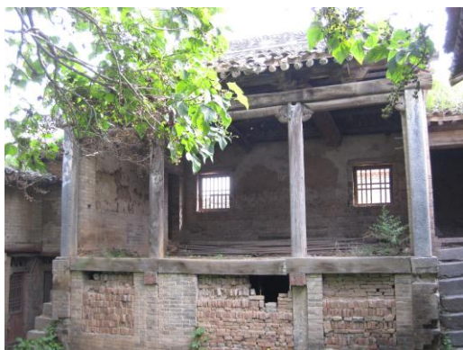
图 14-6 阳城县洽村佛庙舞楼
