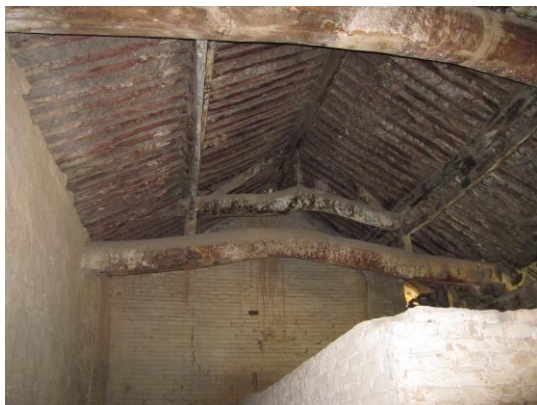
图 12-1 阳城县马寨关帝庙戏台梁架
