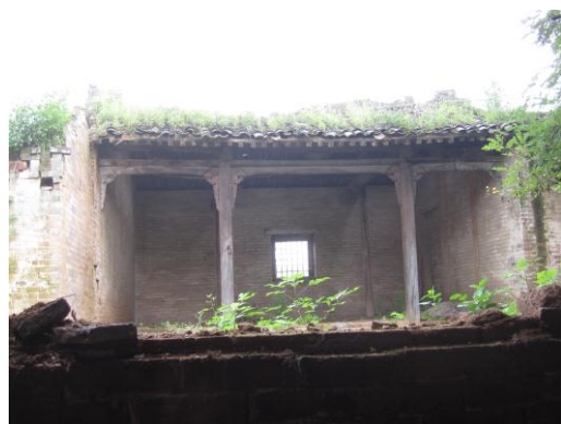
图 15-7 阳城县东河大庙舞楼
