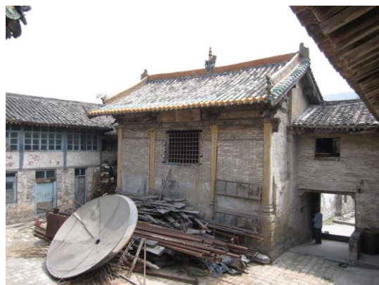
图 2-4 阳城县尹家沟三教堂舞楼
