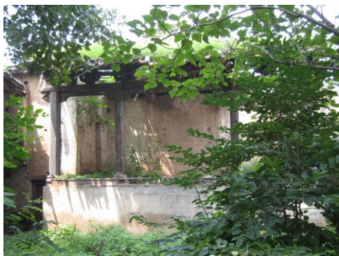
图 17-3 阳城县东樊大庙舞楼
