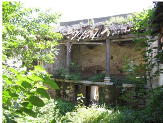
图 17-7 阳城县曹山沟大庙戏台
