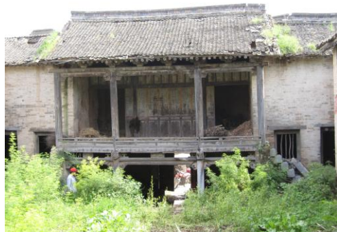
图 18-11 阳城县挫堆关帝庙戏台
