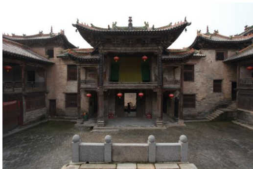
图 15-8 阳城县郭峪汤帝庙戏楼
