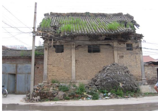
图 15-4 阳城县北留黑虎庙戏台
