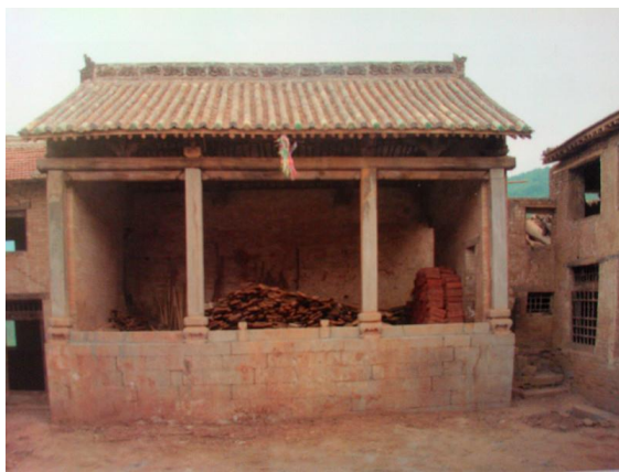
图 4-6 阳城县南峪汤帝庙戏台
