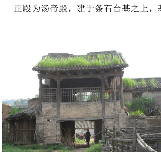
图 5-6 阳城县下伏村汤帝庙戏台
