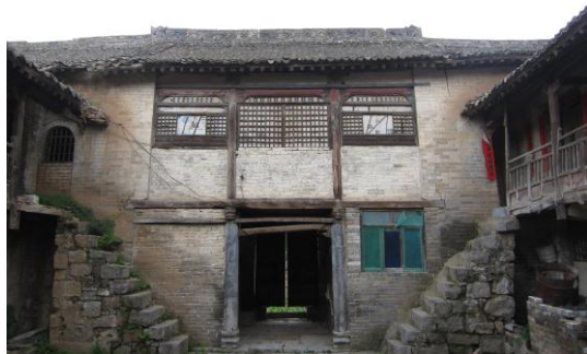
图 9-2 阳城县长辿沟佛庙戏台
