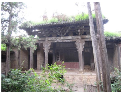
图 5-9 阳城县潘沟关帝庙舞楼
