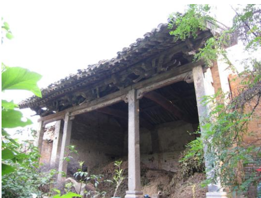
图 3-3 阳城县杨岭汤帝庙戏台
