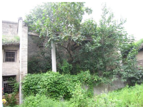
图 14-2 阳城县洪上汤帝庙舞楼
