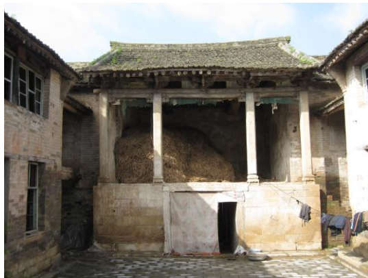
图 16-4 阳城县大西大庙戏台
