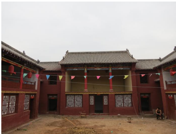
图 4-17 铺头村大庙戏台
