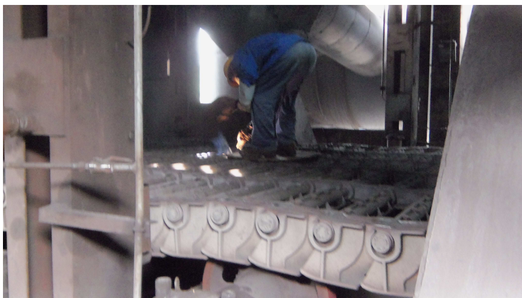
图3.2 链篦机运行中维修篦板
