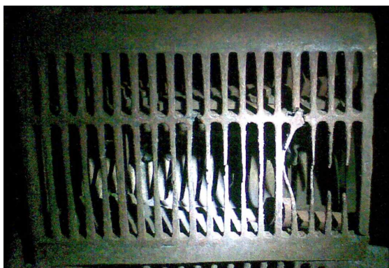
图2.6 篦条磨损断裂的篦板
