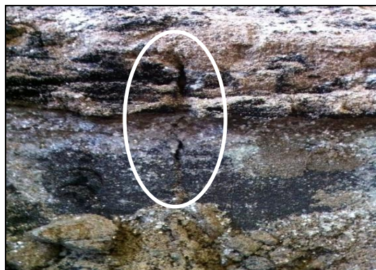
(a)内部贯通裂隙
