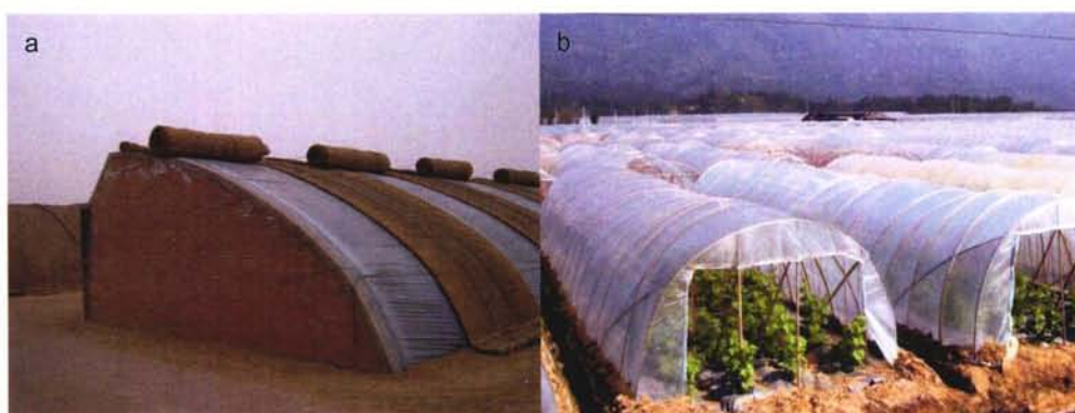
图 4.5 中国北方和南方两种塑料温室的基本类型：(a) 中国北方的日光温室，顶部有塑料薄膜覆盖，其他三面均为砖墙，顶部在冬季可以加盖稻草垫以隔热 (b) 中国南方的拱形塑料温室，由半圆的木质或竹质支撑框架与其上的塑料薄膜组成
