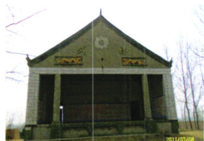
图1—雾灵山奶奶庙山门前的戏台
