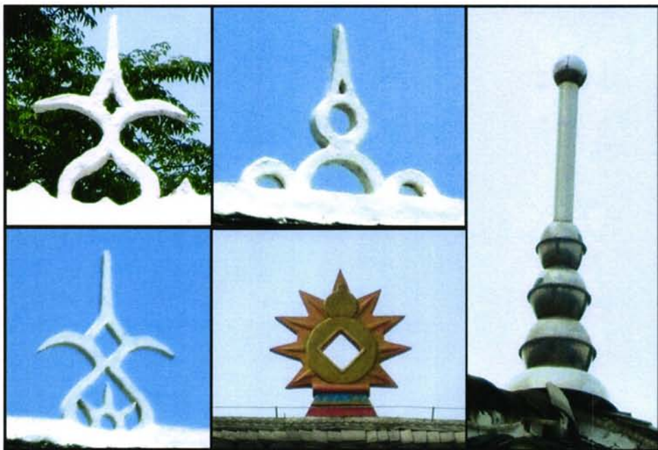
图 3-13 三江侗寨传统建筑屋顶上的“葫芦串”
