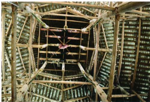
图 3-16 三江平坦寨鼓楼顶部构造
