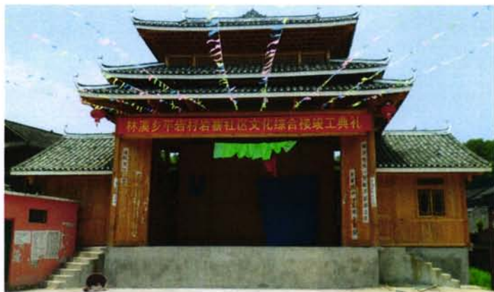
图 4-11 林溪乡平岩村岩寨戏台
