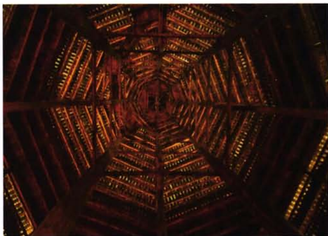
图 3-15 三江鼓楼顶部构造
