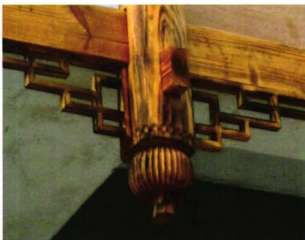
图 4-6 三江侗寨某新建商铺的吊柱
