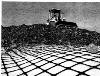
图 3.2.6 土工格栅施工
