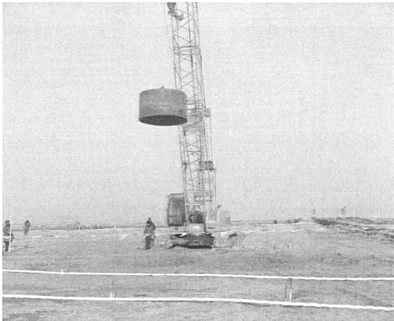
图 1-2 真空动力固结法施工
