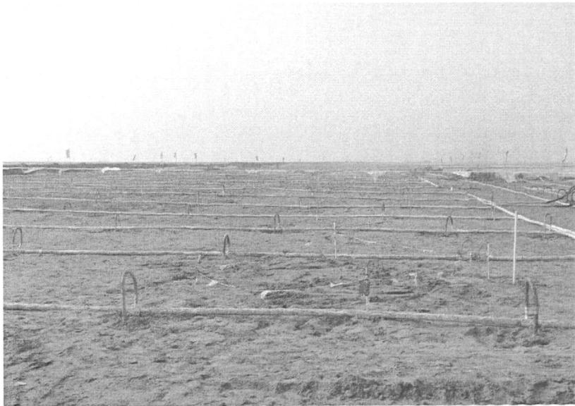
图 4-3 真空降排水管布置
