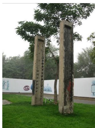
图 4.26 首钢二通机械厂被保留的混凝土结构柱
