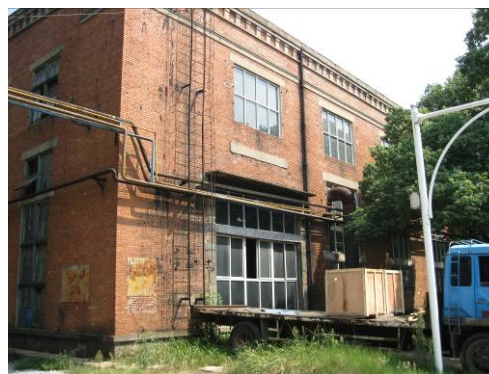
图 4.7 湘潭电机厂内红色砖墙建筑
