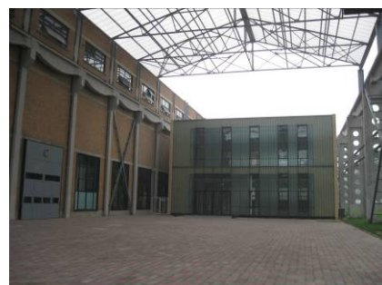
图 4.24 首钢二通机械厂的外部加建
