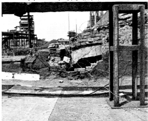
图 4.46 1 线山墙在 B 轴顶破损
