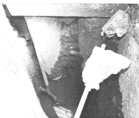
图 4.42 A-37 柱基检测
