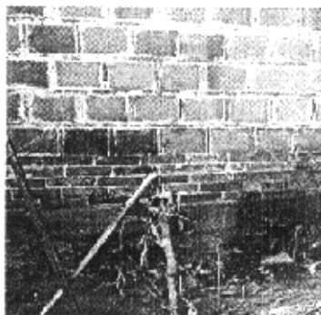
图 5.28 空斗墙底部处理
