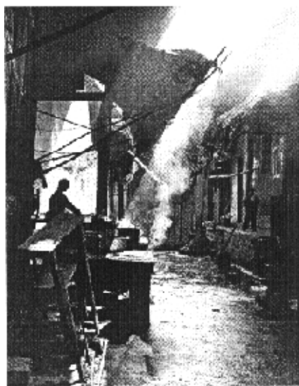
图 3.6 临街搭灶的店宅
