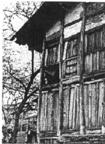
图 5.26 装板与夹壁墙
