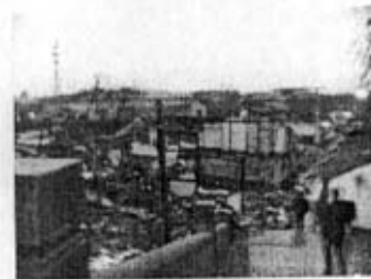
图 1-2 枫桥古镇被毁现场
