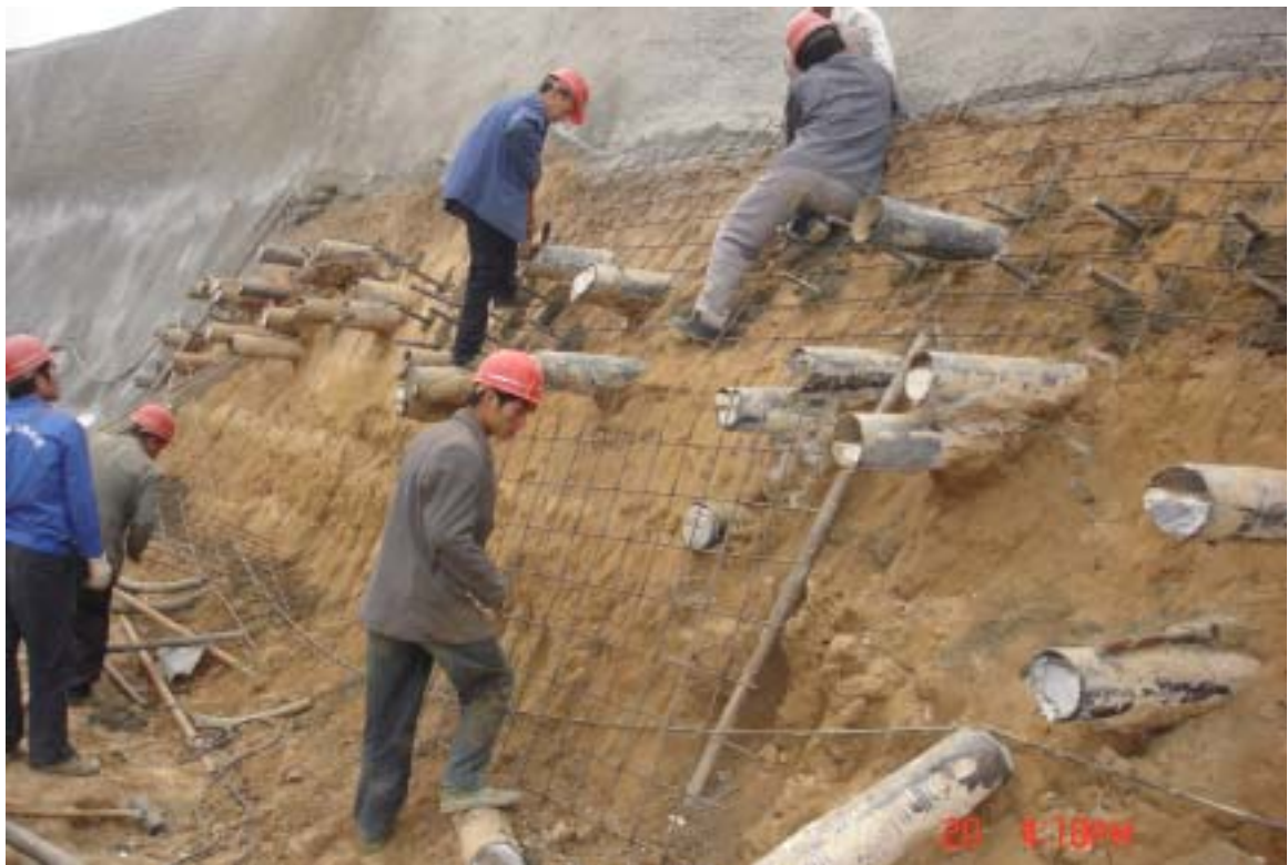
附图12 古运河暗挖段高速南侧大管棚出露图
