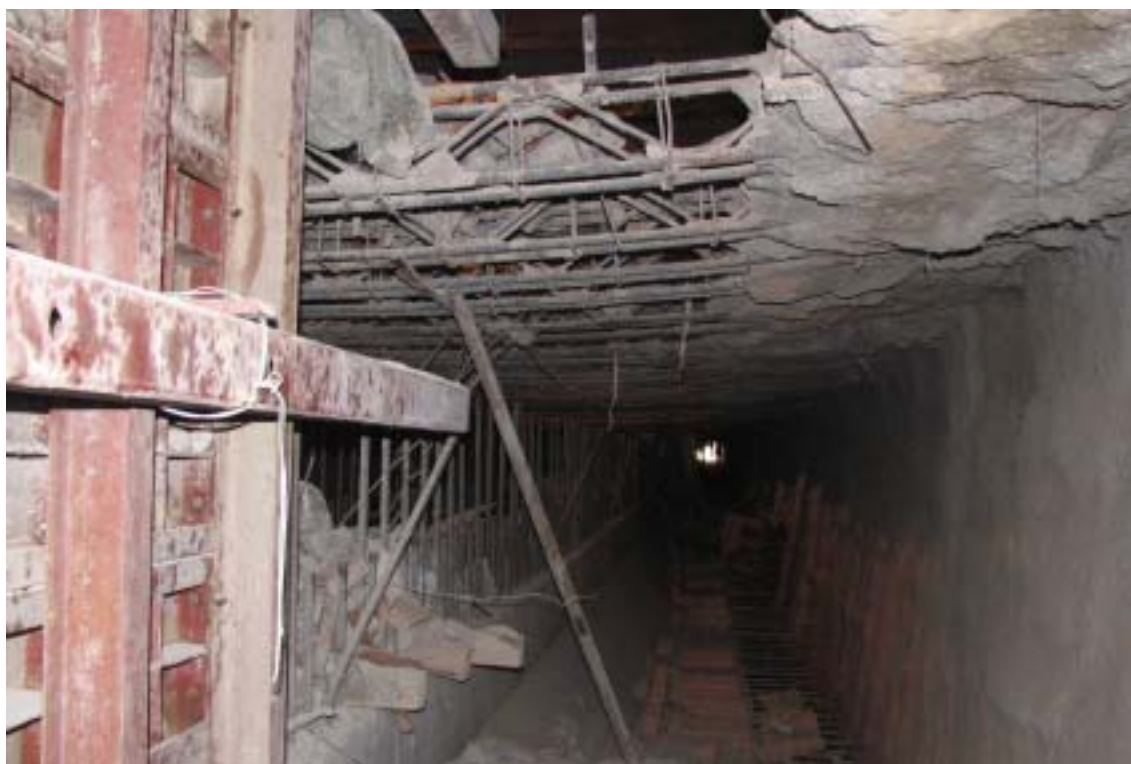
附图8 古运河暗挖段中墙底板混凝土分块浇筑情况
