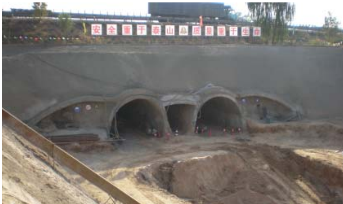
附图2 古运河暗挖段中导洞①部土体开挖
