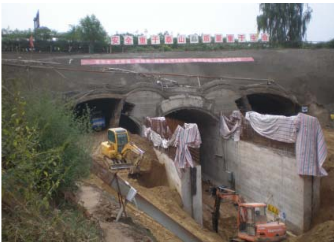
附图9 古运河暗挖段中洞二衬混凝土结构浇筑完成、开挖边洞
