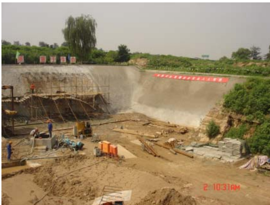
附图1 古运河暗挖段大管棚超前支护
