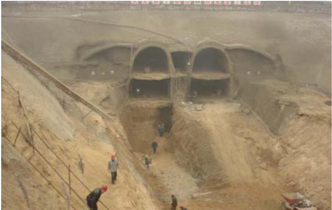
附图3 古运河暗挖段中导洞②部土体开挖
