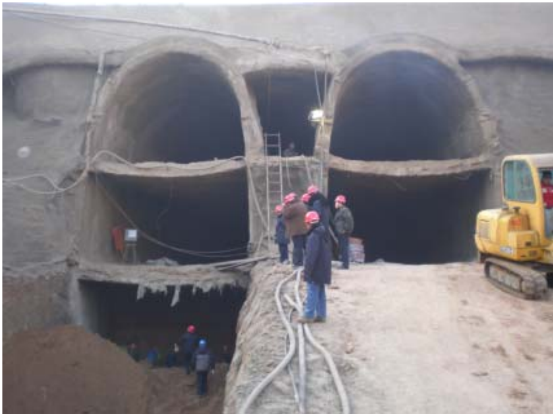
附图4 古运河暗挖段中导洞③部土体开挖
