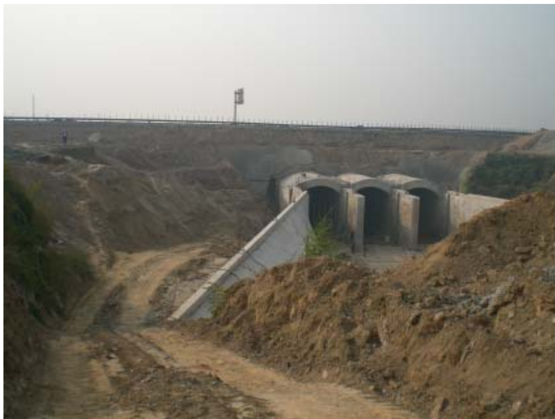
附图10 古运河暗挖段拱涵结构全部贯通
