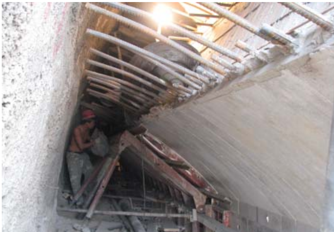
附图7 古运河暗挖段中墙蘑菇顶施工缝及钢筋接头分布
