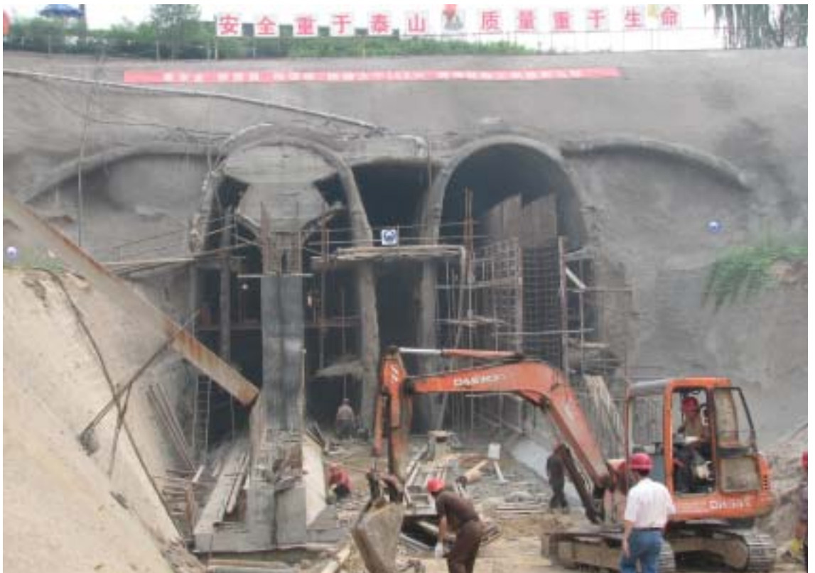
附图6 古运河暗挖段中导洞一衬拆除、浇筑中墙
