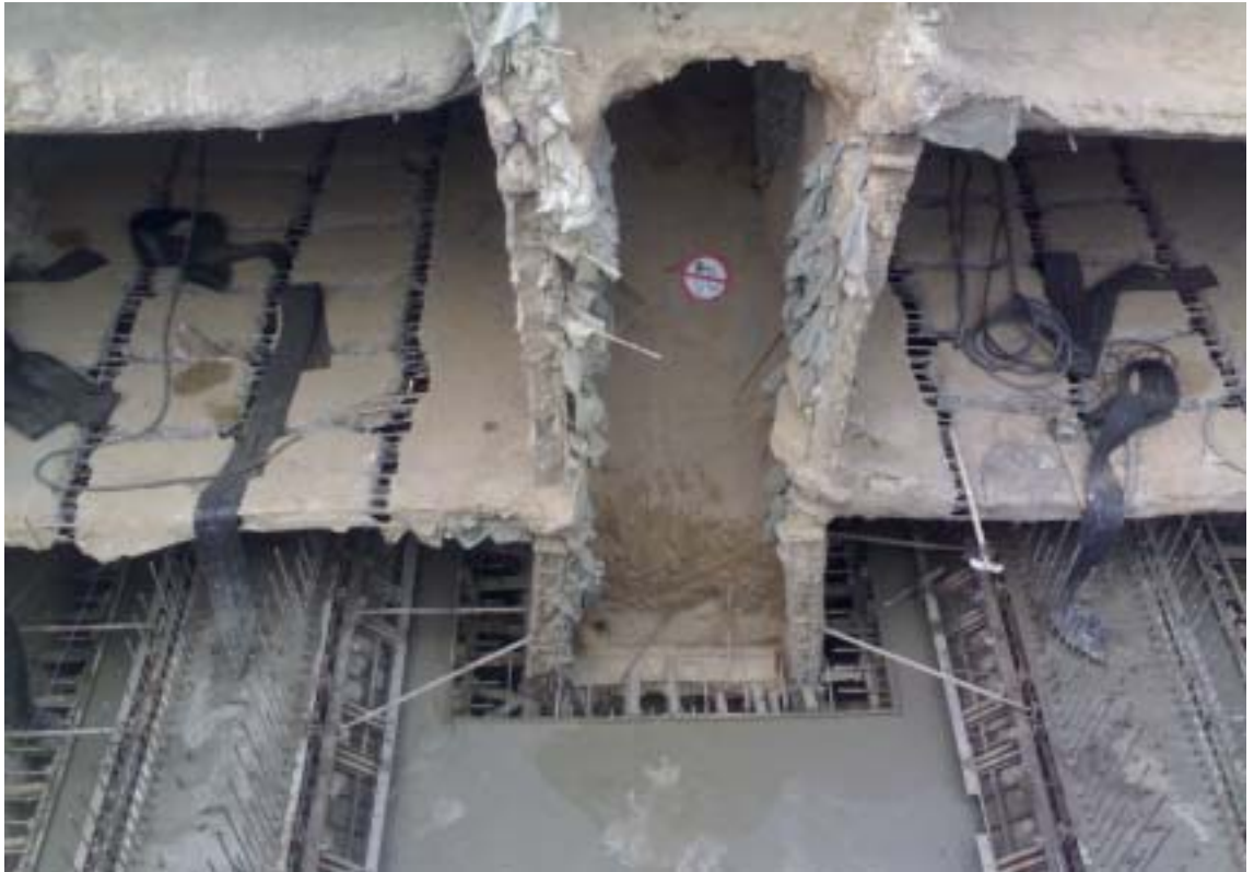
附图5 古运河暗挖段中墙底板混凝土浇筑
