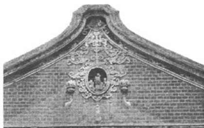
照片 4-4 山墙悬鱼
