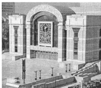
图 5-19 新天桥剧场东面实景照片
