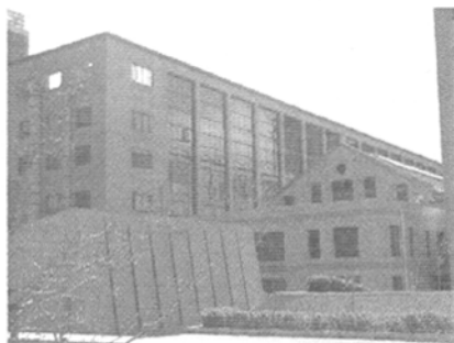
图 6-3 原光华染织厂内被改建的工业建筑 (东郊棉纺区工业用地) 资料来源:自摄
