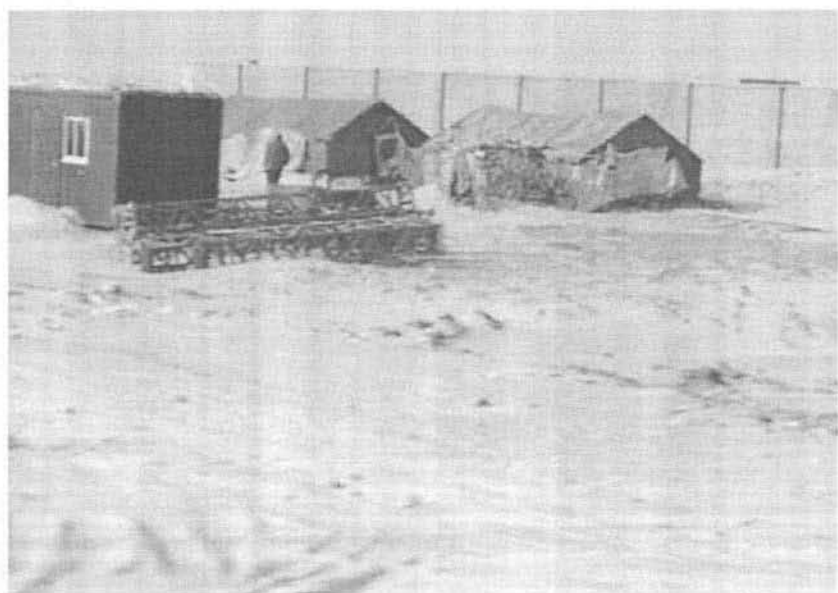
图 5-19 建设中的曹妃甸之三
