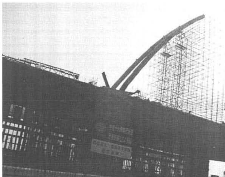
图 5-16 建设中的迁曹铁路
