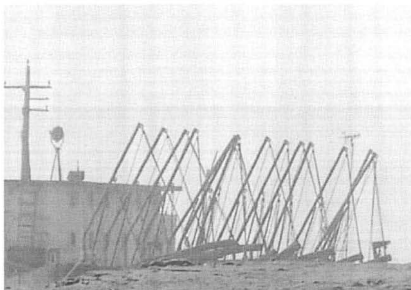
图 5-18 建设中的曹妃甸之二
