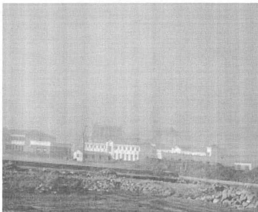
图 5-15 曹妃甸施工现场
