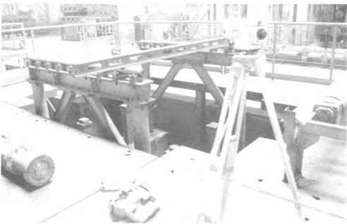
图8 扇形段对弧台架测量 Fig. 8 Test of segment alignment stand
