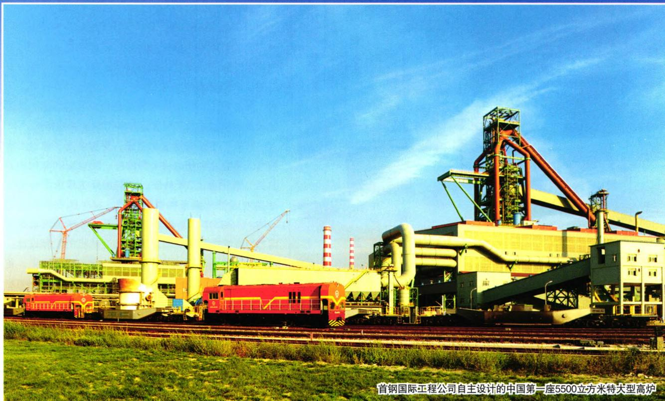
首钢国际工程公司自主设计的中国第一座5500立方米特大型高炉
