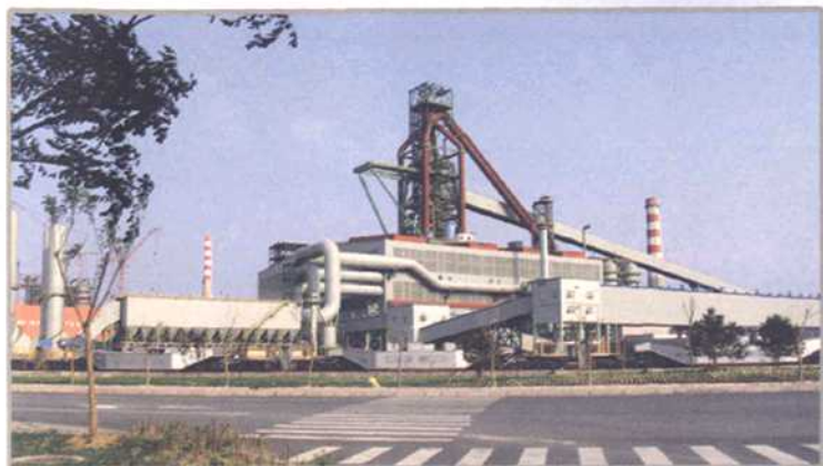
由首钢国际工程公司自主设计、集多项世界领先技术于一身的京唐5500立特大型高炉
