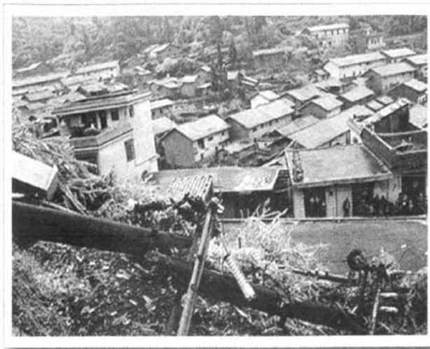
1月30日,广东省南雄市油山、坪田等地遭遇低温雨雪冰冻灾害,电线杆折断
