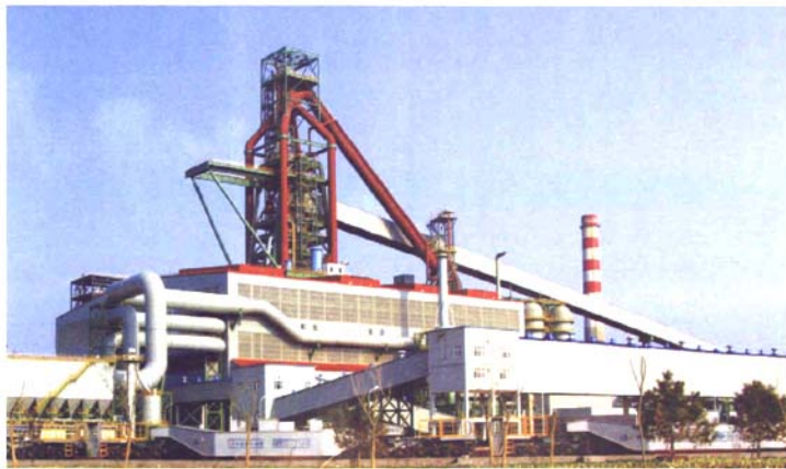
□ 由首钢国际工程公司自主设计、集多项世界领先技术于一身的京唐5500m特大型高炉。
