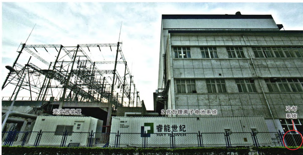
石景山热电厂储能系统,整套系统置于发电机组一侧,布局灵活
