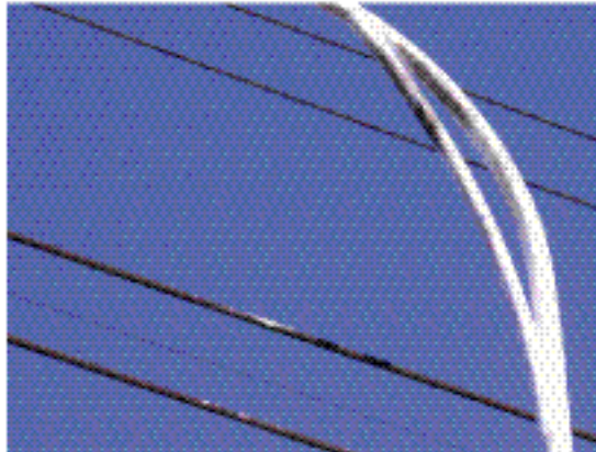
图 3 220 kV 架空线风闪故障点
