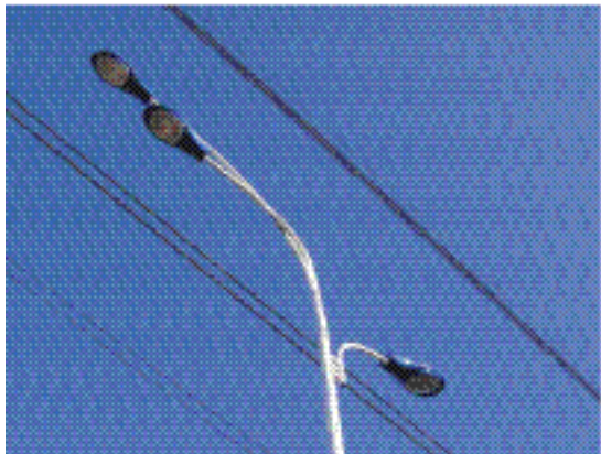
图 3 220 kV 架空线风闪故障点
