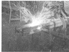
图4 切割筋板
