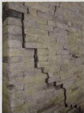
图3 西山墙裂隙
