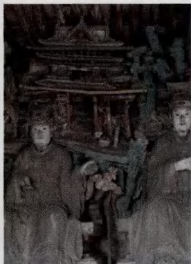
图4 北墙西侧悬塑变形
