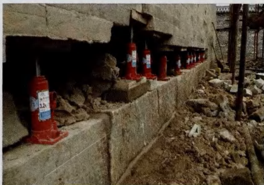
图10 墙体托换现场
