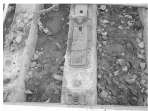
图1 桥梁道床污染板结
