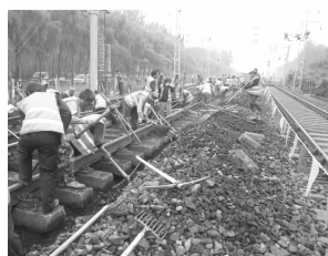
图4 齿条压机“打起” 线路后人工清筛
