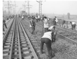
图5 桥梁换砟后 大机捣固回填
