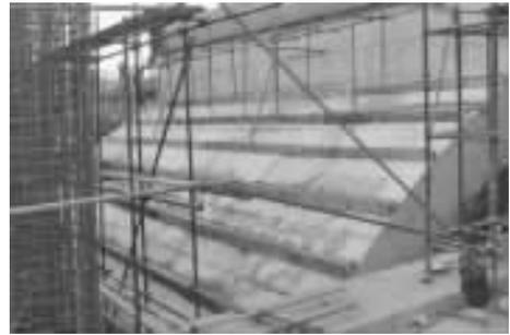
图5 拱上支架基础混凝土浇筑
