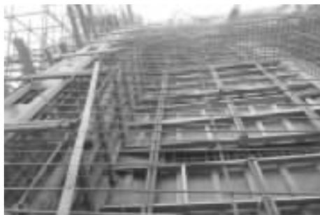
图2 拱圈箱室及侧腹板压模模板
