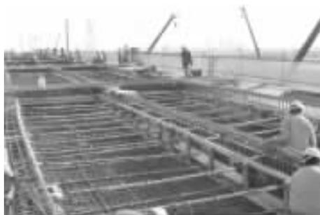
图8 现浇箱梁混凝土浇筑
