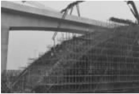
图3 拱圈混凝土浇筑
