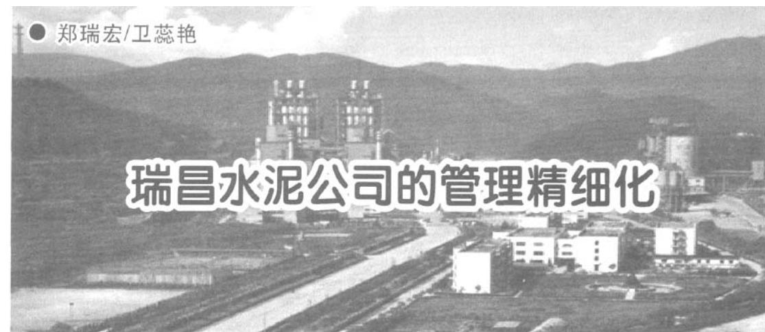
首钢长治钢铁有限公司是全国最大的500家工业企业之一,也是山西省钢铁企业大户。为合理利用高炉废渣,做强做大首钢长钢公司,提高竞争力,抵御市场风险,2001年公司及时调整产业结构,开辟了新的经营领域,由此瑞昌水泥公司诞生了。瑞昌水泥公司是2003年投产建成的年产100万吨的新型超细矿渣水泥生产企业,企业从项目策划、论证到投产、达效,始终贯穿了“世界先进,国内一流”的建设理念。LM56.2+2S矿渣立磨全套引进德国装备,输送、搅拌系统选用美国产品,生产控制采用了信息化控制较高的DCS集散控制系统,工艺设计使用世界领先的分别粉磨技术。2005年,中国水泥协会会长雷前治先生到我公司视察后欣然题词“中国水泥第一磨”。
