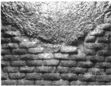
图 2 鱼雷罐使用 653 次罐口下部过铁处侵蚀状况
