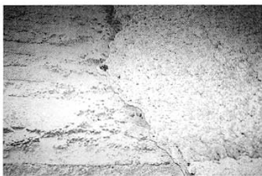
图9 首钢2号高炉7段西北部渣皮现场
