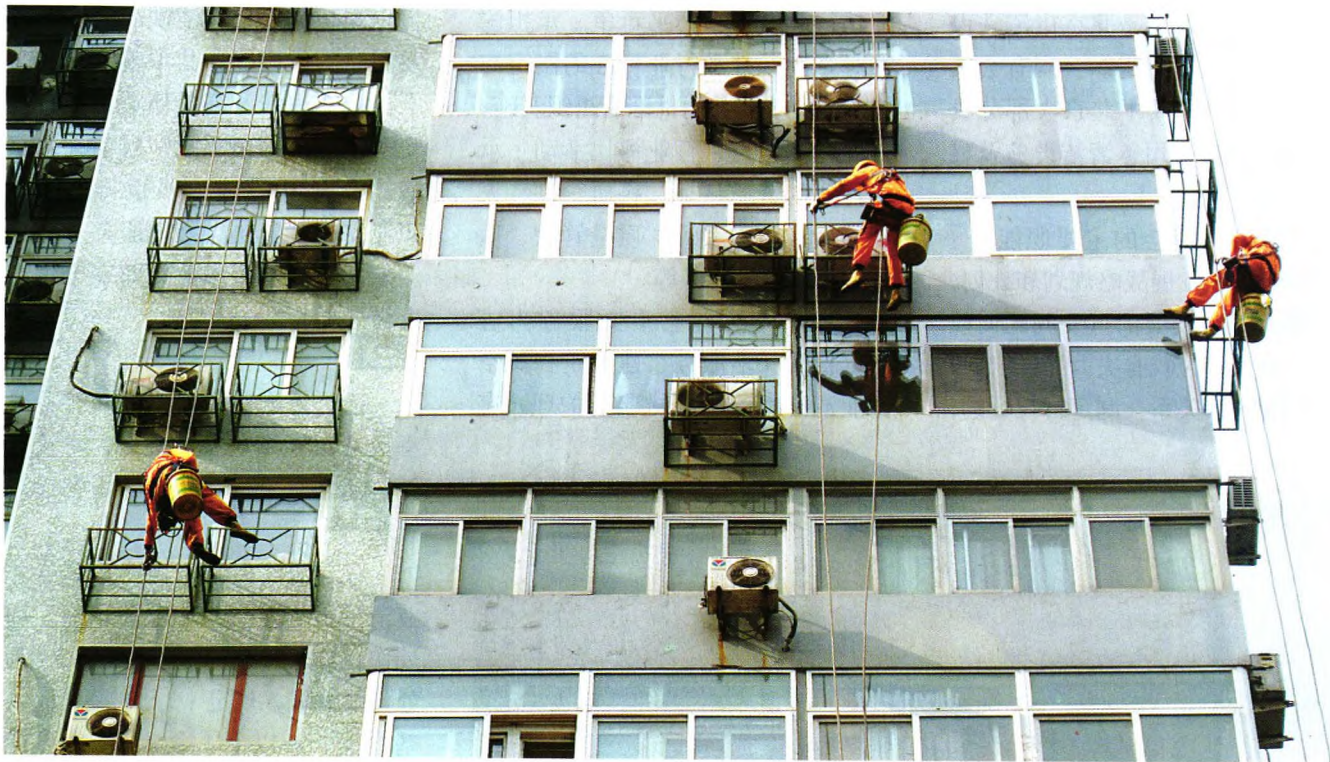
正在进行空调室外机检修的“蜘蛛人”
