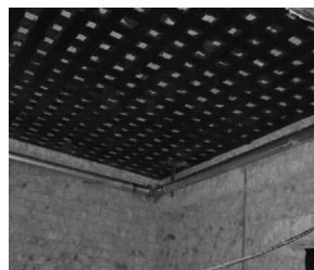
图 2 粘碳纤维加固法
