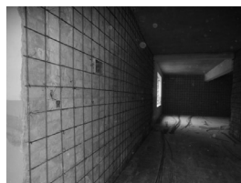
图4 墙体喷射混凝土加固法
