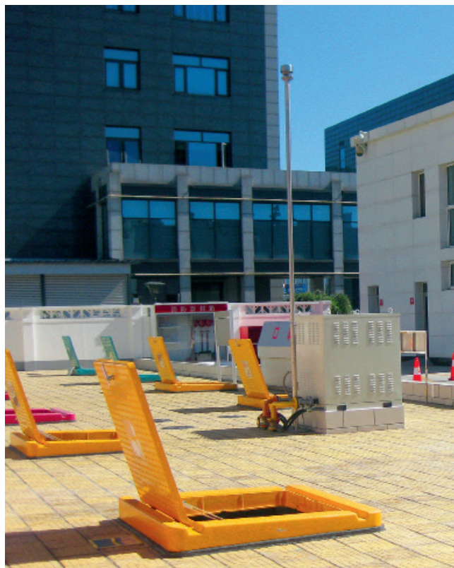
► 从双层油罐到复合材料操作井，“贯标”改造的鑫邦达加油站焕然一新。供图/胡玮斐
