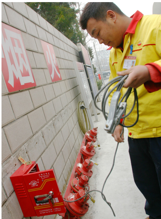
► 人体静电释放仪帮助卸油员释放身体所带静电。 摄影/本刊记者 杨春雁
