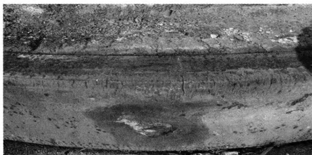
图1 阀板下部吹扫出的裂纹
