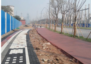
图12 北京凉水池东路 (二灰稳定再生无机混合料、再生透水混凝土、再生透水砖)
