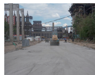
图8 冬奥广场周边道路工程 （二灰稳定再生无机混合料）
