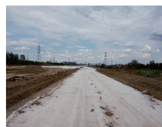
图7 长安街西延道路工程 （水泥稳定再生无机混合料）
