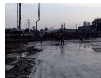
图10 首钢土壤修复气膜大棚工程 （再生混凝土C20，P12）
