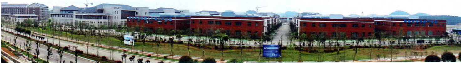
贵安新区标准厂房建设全景
