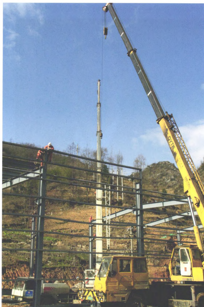
科技孵化园标准厂房建设
