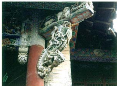
图4 亳州大关帝庙戏台斜撑
