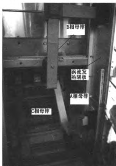
图 1 1# 高炉发电机计量柜
