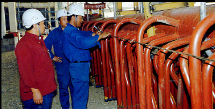
精心选择吊点，是确保安全和吊装质量的关键，每次起吊前，王昌军都要和同志们一道仔细测量，精选吊点。
